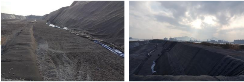
[광양 매립장 복구공사 현장]
